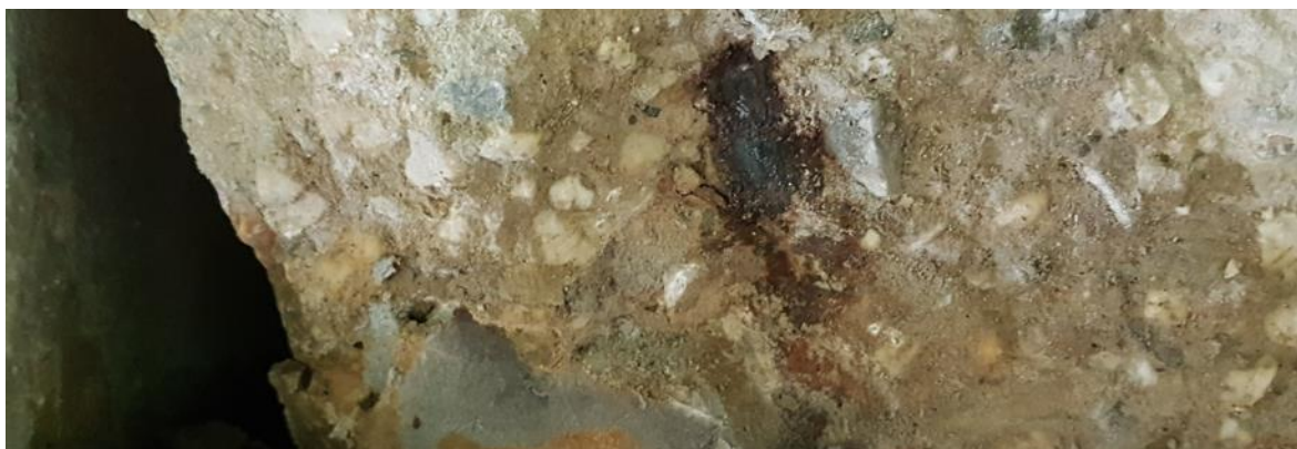
Figuur 22: Foto van de ligger bij het steunpunt (betonschade en wapeningscorrosie).
