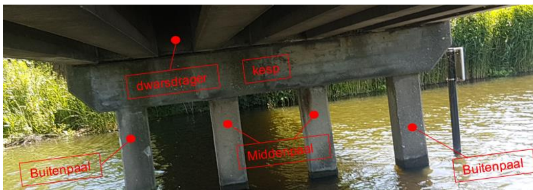
Figuur 14: Foto middensteunpunt met benaming bouwdeelen
