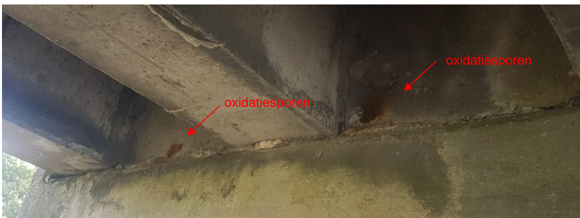
Figuur 12: Foto van de dwarsdrager van het middensteunpunt (Oxidatiesporen).
