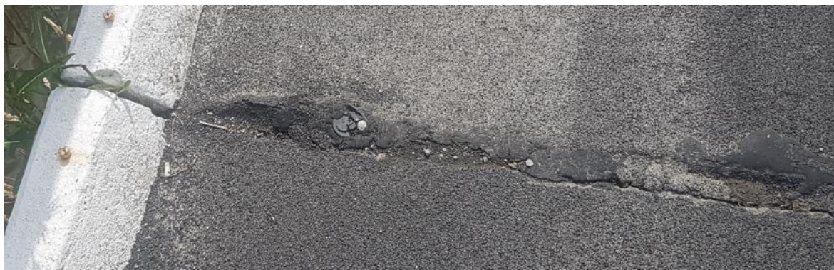
Figuur 9: Foto van de dilatatievoeg t.p.v. het middensteunpunt.
