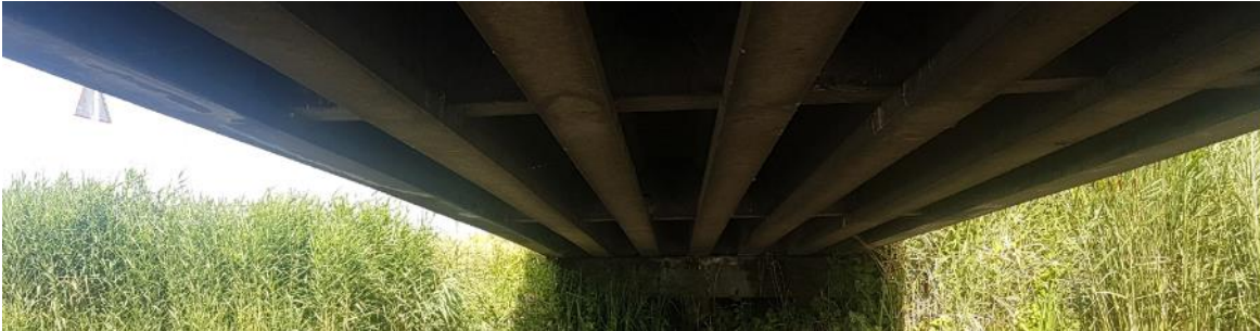
Figuur 10: Foto van de onderkant brugdek (voorgespannen draagliggers).
