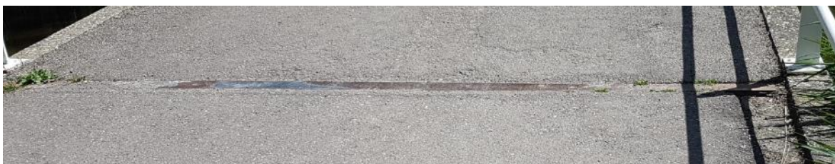
Figuur 18: Foto van de dilatatievoeg t.p.v. het middensteunpunt.
