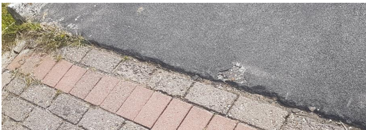
Figuur 8: Foto van de dilatatievoeg t.p.v. het middensteunpunt.
