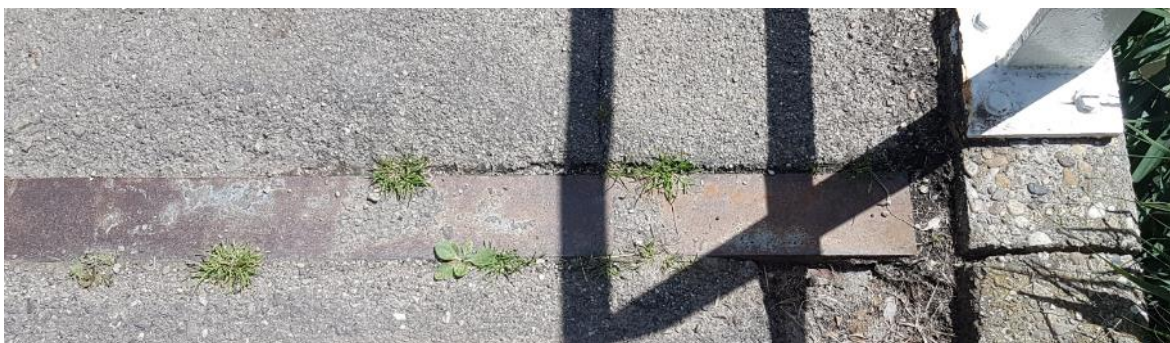
Figuur 19: Foto van de dilatatievoeg t.p.v. het middensteunpunt.
