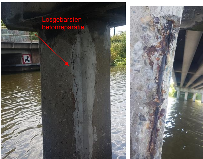
Figuur 11: Foto van de palen bij het middensteunpunt (betonschade en wapeningscorrosie).
