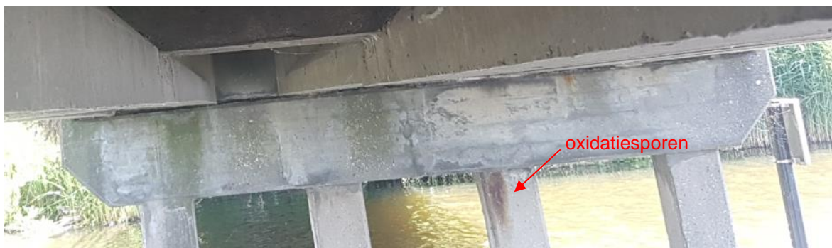
Figuur 13: Foto van het middensteunpunt (Oxidatiesporen).
